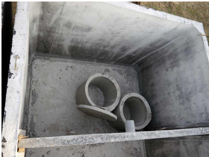
Zbiornik podziemny do gromadzenia wody deszczowej o pojemności 10 m 3
